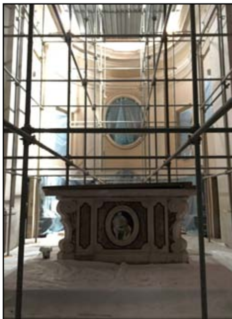
Ponteggio all'interno della chiesa
